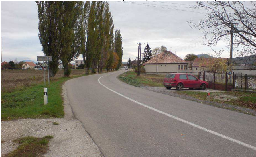
obr. 46 Cesta III/513016 – smer k obci Čab
