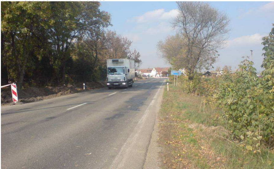
obr. 45 Cesta III/513015 rozhranie obcí Zbehy a Čakajovce – smer k obci Čakajovce
