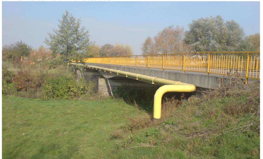
obr. 48 Most cez rieku Nitra na ceste I/64
